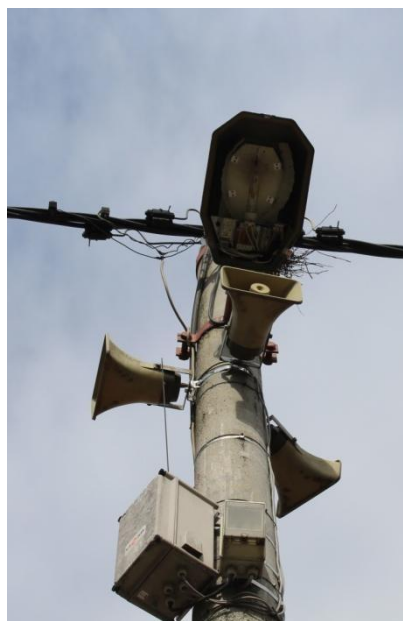
Srbce SM č.16 – chybějící kryt (difuzor)
