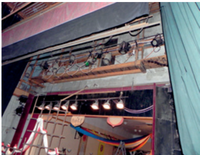
světelný park jeviště před rekonstrukcí
