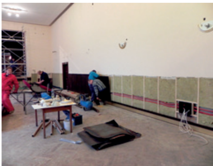
instalace nového obložení
